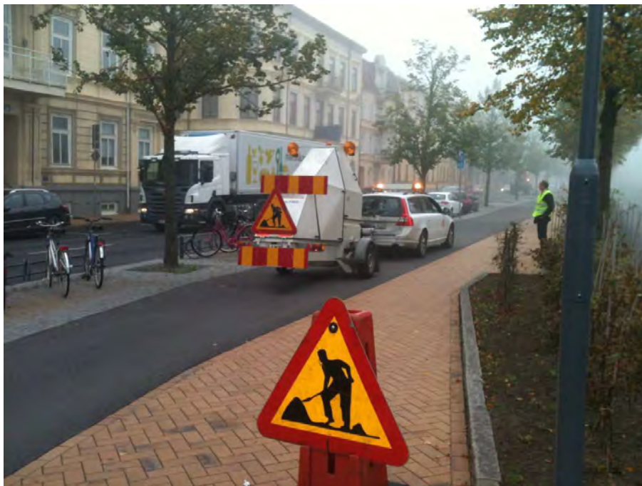
Figur 23. Mätning av skelettjord i cykelbana vid Västra Boulevarden, Kristianstad.
