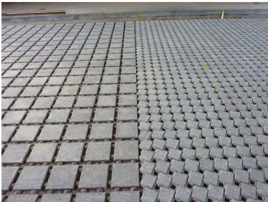
Figur 6. Bilden visar ytan med dränerande marksten innan test. Marksten med 20 % infiltration till vänster och marksten med 10 % infiltration till höger.
