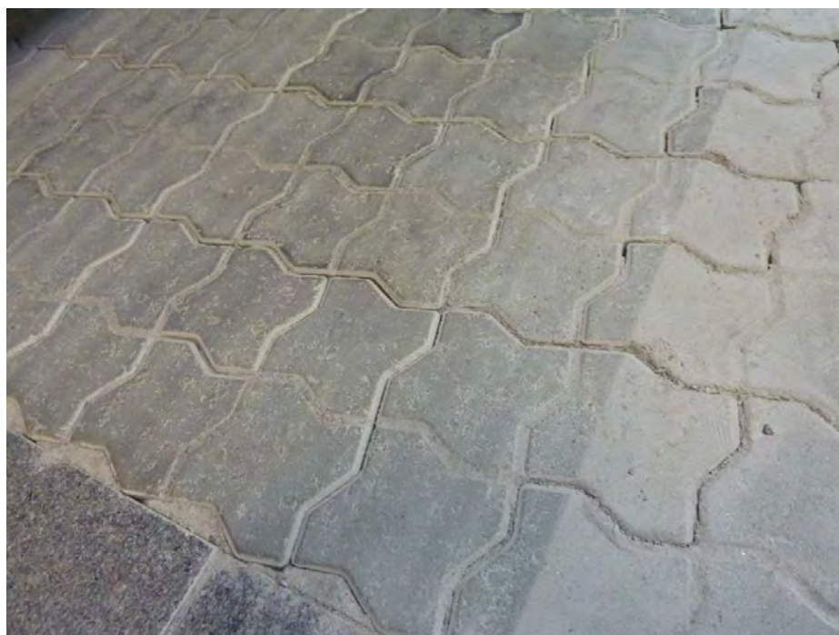
Figur 13. Markstensyta med Starka Coloc.
