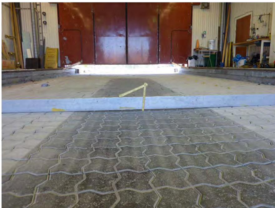
Figur 17 Spår djup i betongmarkstenarna efter HVS-försöket.
